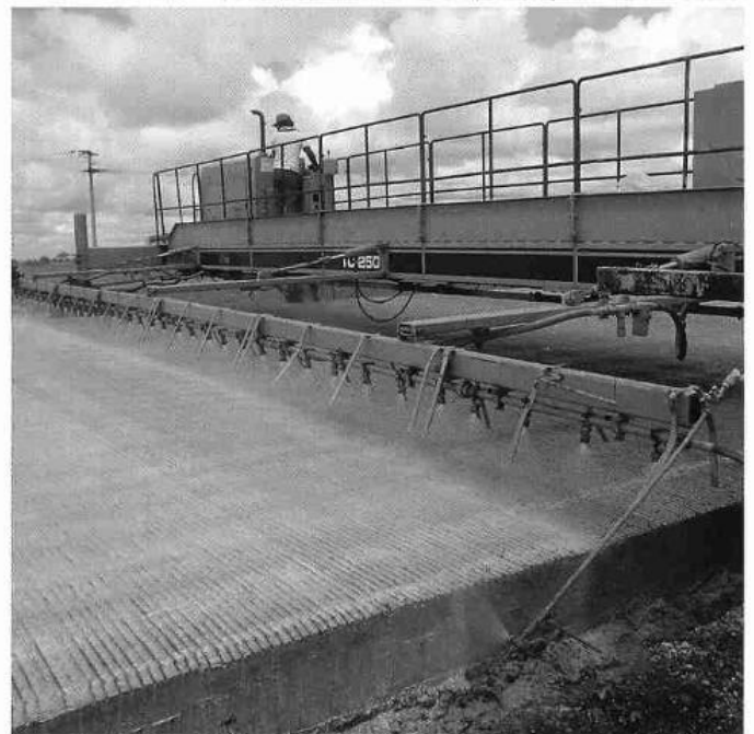
Máquina texturizadora para la colocación de la carpeta rígida de concreto.
