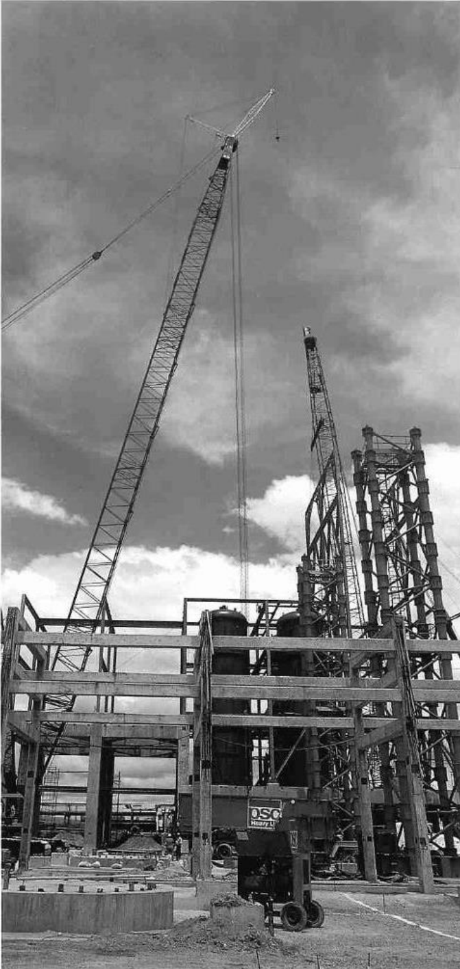
Maniobras de montaje de equipo de proceso.
