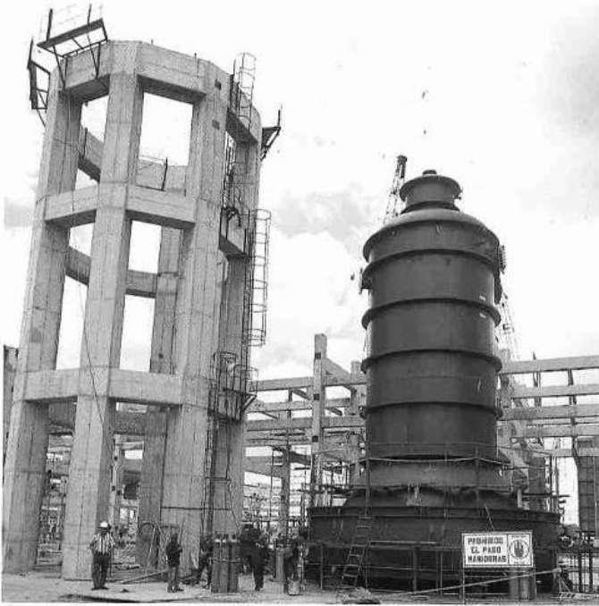
Inicio del ensamble en sitio de la torre de vacío.
